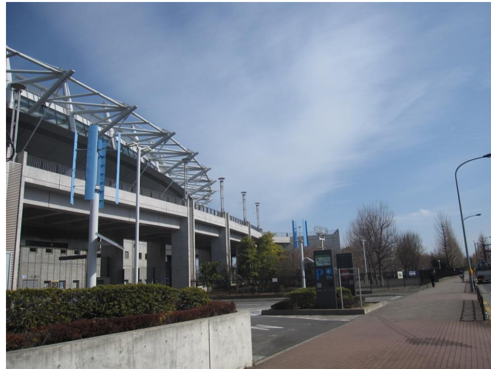
甲州街道沿いのスタジアム入口に2基設置
